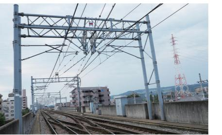
■ 仙台市地下鉄南北線カテナリー電車線路設備
